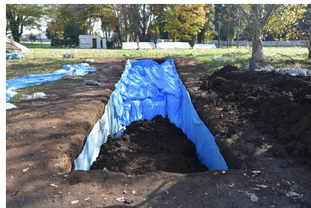
写真8 ブルーシートによる養生 ②
