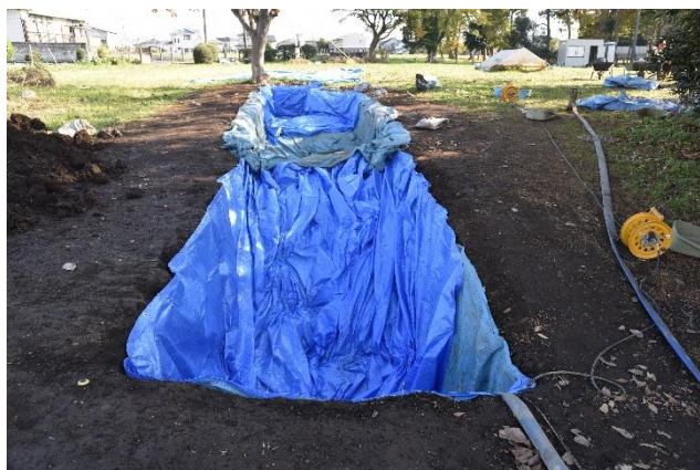
写真7 ブルーシートによる養生 ①
