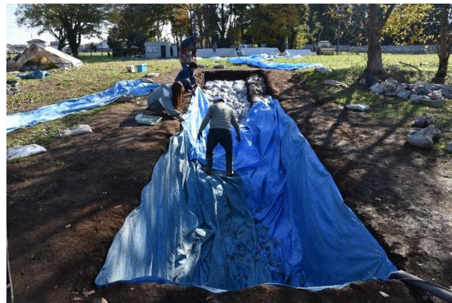
写真6 土嚢とブルーシートによる遺構保護 ②
