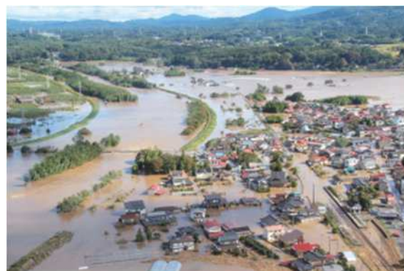
浸水被害の状況（福島県須賀川市） 出典：消防庁「令和2年3月消防の動き587号」
