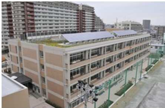
▲全市立学校（167校）への太陽光発電設備及び蓄電池の導入
