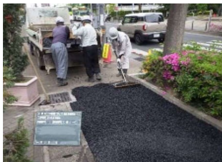
【道路緊急修繕】
