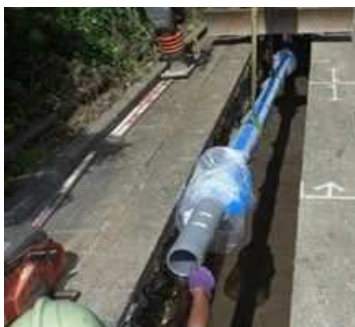
老朽管更新工事
