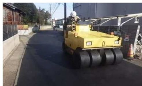
道路の緊急修繕
