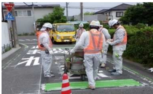
交通安全施設の修繕
