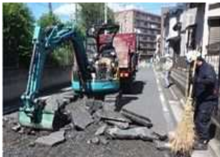
道路緊急修繕
