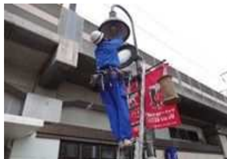
交通安全施設修繕
