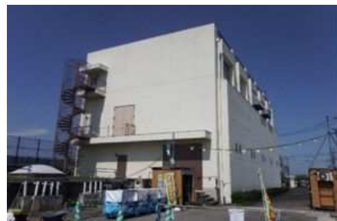
北部配水場更新工事
