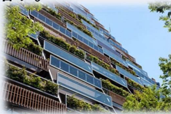
▲参考事例 太陽光パネルの壁面利用 (豊島区役所) 出典：豊島区庁舎(東棟)
