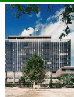
<岡山市現庁舎>
