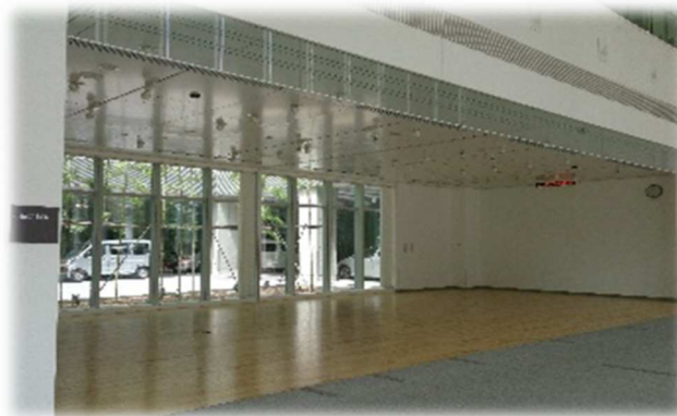
▲参考事例 甲府市役所 駐車場と一体利用可能な市民コミュニティホール 1階窓を開放すると隣接する屋外駐車場と一体的な利用が可能となっている。 出典：甲府市ホームページ
