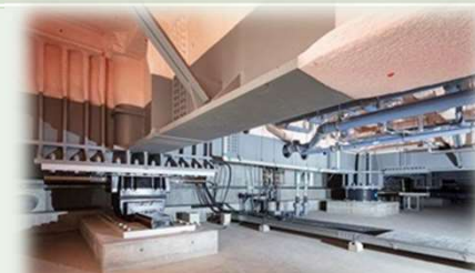
▲参考事例 地下免震装置 (越谷市役所) 出典：越谷市ホームページ
