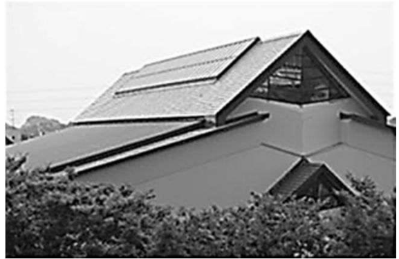
【大宮武道館の太陽光発電設備(32.3kW)】
