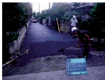
道路緊急修繕
