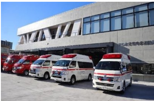
【中央消防署（令和3年12月供用開始）】
