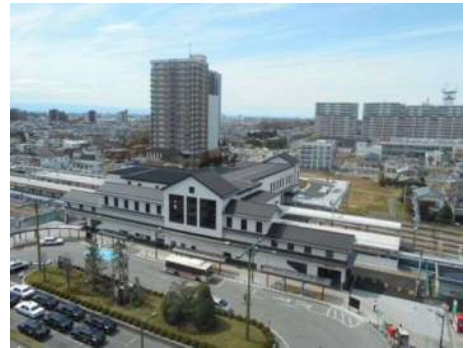
<岩槻駅(東口側)駅舎>
