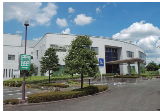
大宮南部浄化センター
