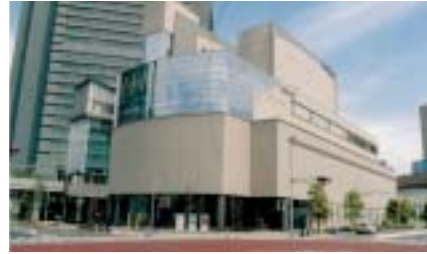
※手前建物の3・4階部分
