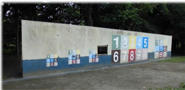
作業前のシュート板
