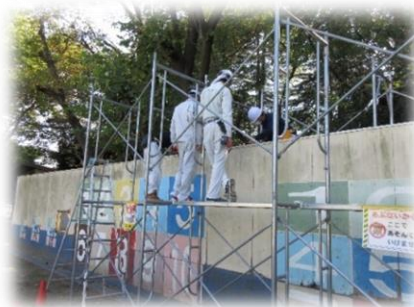
改修作業中の大宮工業高校の生徒たち（2021）
