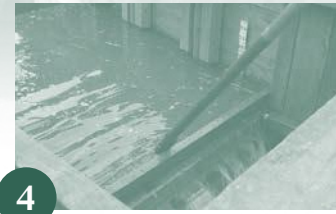
4 角落板を取り付ける。関枠の鳥居柱(関枠中央の太い柱)と水圧によって、角落板が固定される。
