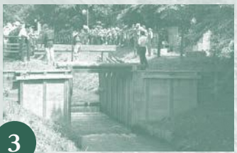
3 一の開に角落板を3枚取り付け付けたところ(手前が芝川側)。関枠より上流部分の水位が徐々に上昇していく。
