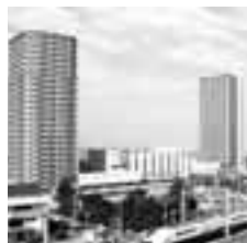
▲武蔵浦和駅第4街区
