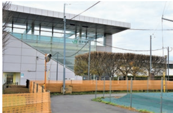
開業以来不便な状況が続く西大宮駅南口。一日も早いロータリーの整備が求められる。
