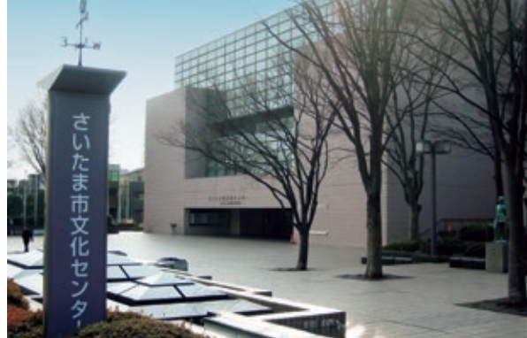
昭和60年に開館し築38年の文化センター 快適に利用できる大規模改修が望まれる
