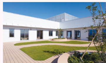
緩和ケア病棟に面する屋上です。
