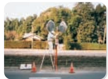
カーブミラー修繕
