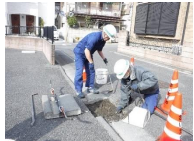
土木緊急修繕
