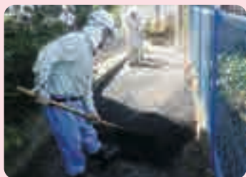
道路等の損傷箇所の早期発見・補修
