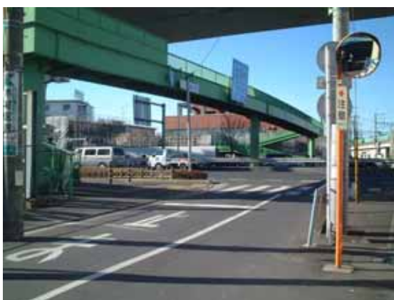
バイパスの東西を結ぶのは、駅南側の老朽化した歩道橋
